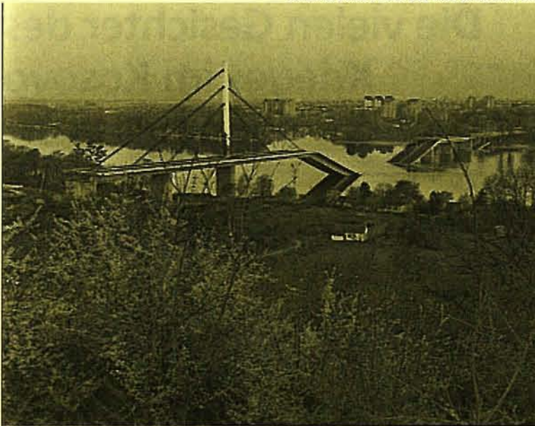
Zerstörte Brücke in Novi Sad. Foto: Serbia Info News
