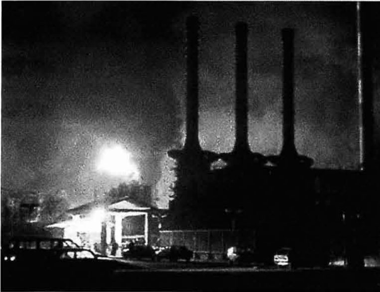
Heizkraftwerk in Neu Belgrad. Foto: Serbia Info News
